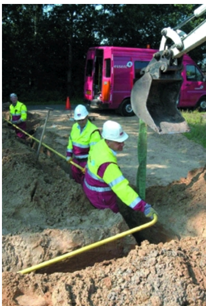
Monteurs van Essent bezig met het leggen van een gasbuis.
